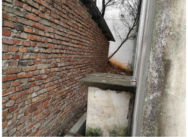
东墙外排风口及过道
