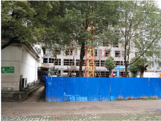
放疗大楼南面在建大楼
